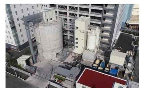
敷地面積は約 2,195 m<sup>2</sup>(665 坪)で、現在の品川工場と比べ 4 分の 3 ではありますが、RC製骨材集中サイロや骨材受入とプラント供給の 2 本の垂直ベルトコンベアの採用、セメントサイロを RC 製の架台上に配置することで、下部でバラ車の荷卸しができる等、敷地面積に対応したレイアウトとなっております。
