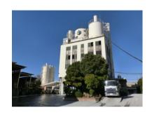
約40年前に建てられたプラントはビル型プラントであり、1階から6階までにバッチャープラント、試験室、配車室、事務室等を一つに納めた珍しい建物となっております。さらに、屋上には200tのセメントサイロが4基あることも特徴的です。その中で試験室は3階に配置していることから、骨材等の材料を搬入する際はエレベーターを使うなど手間が掛かりますが、効率よく仕事ができるようにさまざまな工夫をしております。
